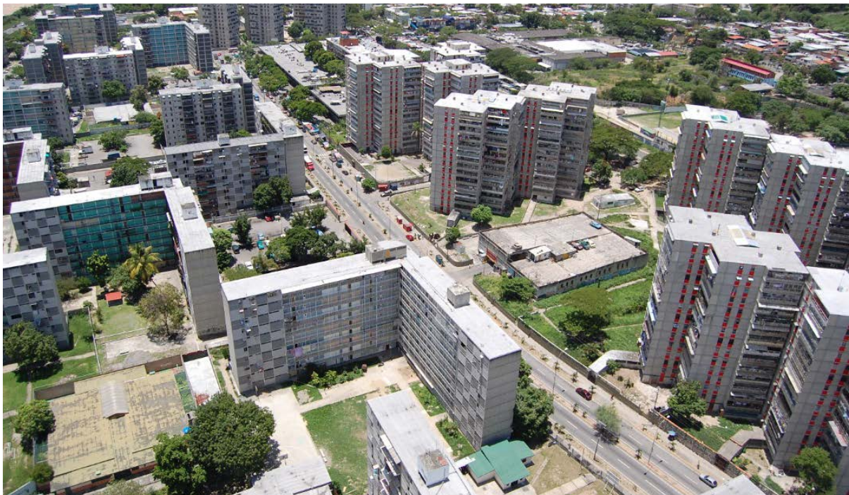
Urbanización 27 de Febrero. Guarenas. Municipio Plaza. Edo. Miranda.
